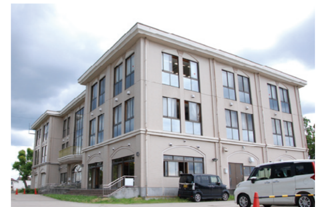
新方地区センター・公民館
