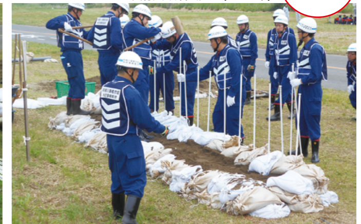
積み土のう工
