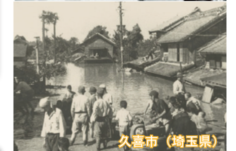
カスリーン台風によるしん水ひ害の様子 (提供：国土交通省利根川上流河川事務所)
