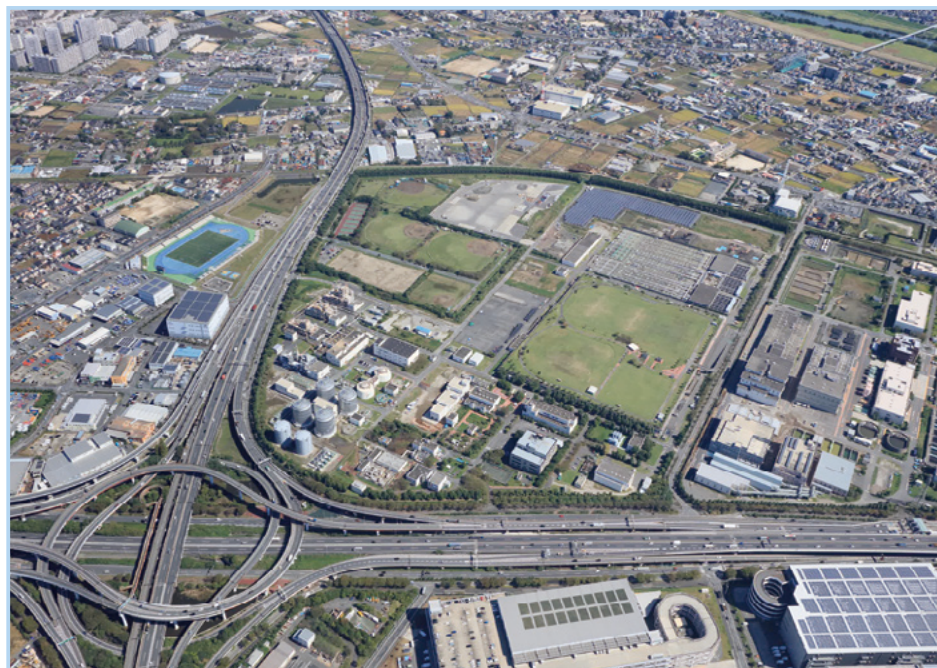
中川水循環センター（埼玉県三郷市）
