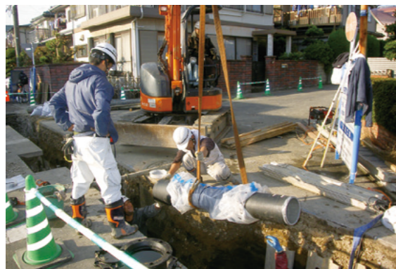
水道管の取りかえ
