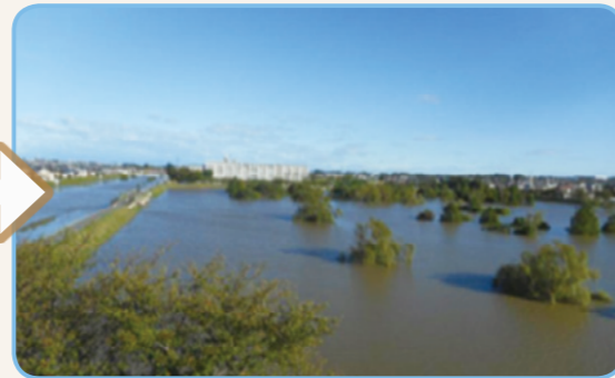
大吉調節池（雨天後）
