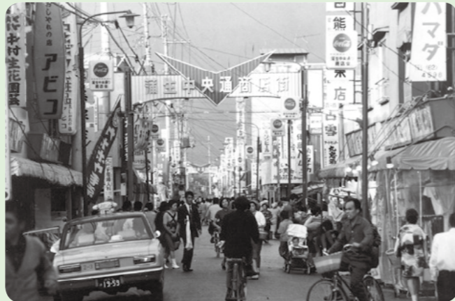
蒲生中央通り商店街 (昭和45年)
